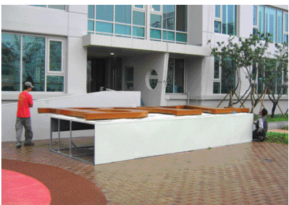
▲ 이 장면은 33층의 추상적인 건물이다. 현재 8층 시공 옥상에 미리 사출된 채널 문자를 이용한 상태. 고층의 작업 전에 기사들이 현장의 상태를 정례하고 있다. 이와 같은 방법은 매우 전문성이 있는 기사들의 확인이어서 믿을 만하지만 고도의 기술과 전문성을 가진 건설사만이 한다는 점이 문제다.
