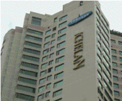
작업 중간의 정도의 시공 상태.
